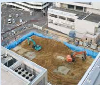
現在、解体工事完了、一次掘削・地盤改良工事を完了し、基礎工事に着手しました。
